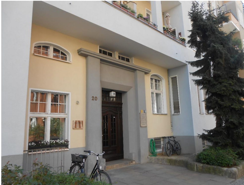
1 Der Eingang zur Bozener Straße 20
